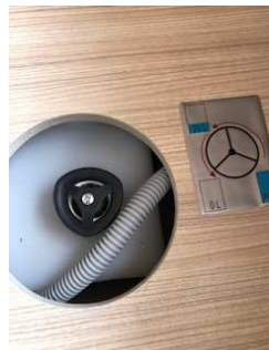
Valvola chiusura serbatoio
